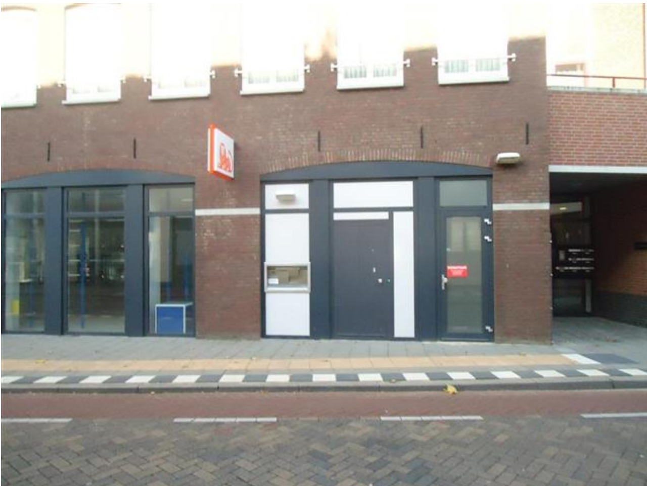
Foto nachtkluis met eigen toegangssluis
