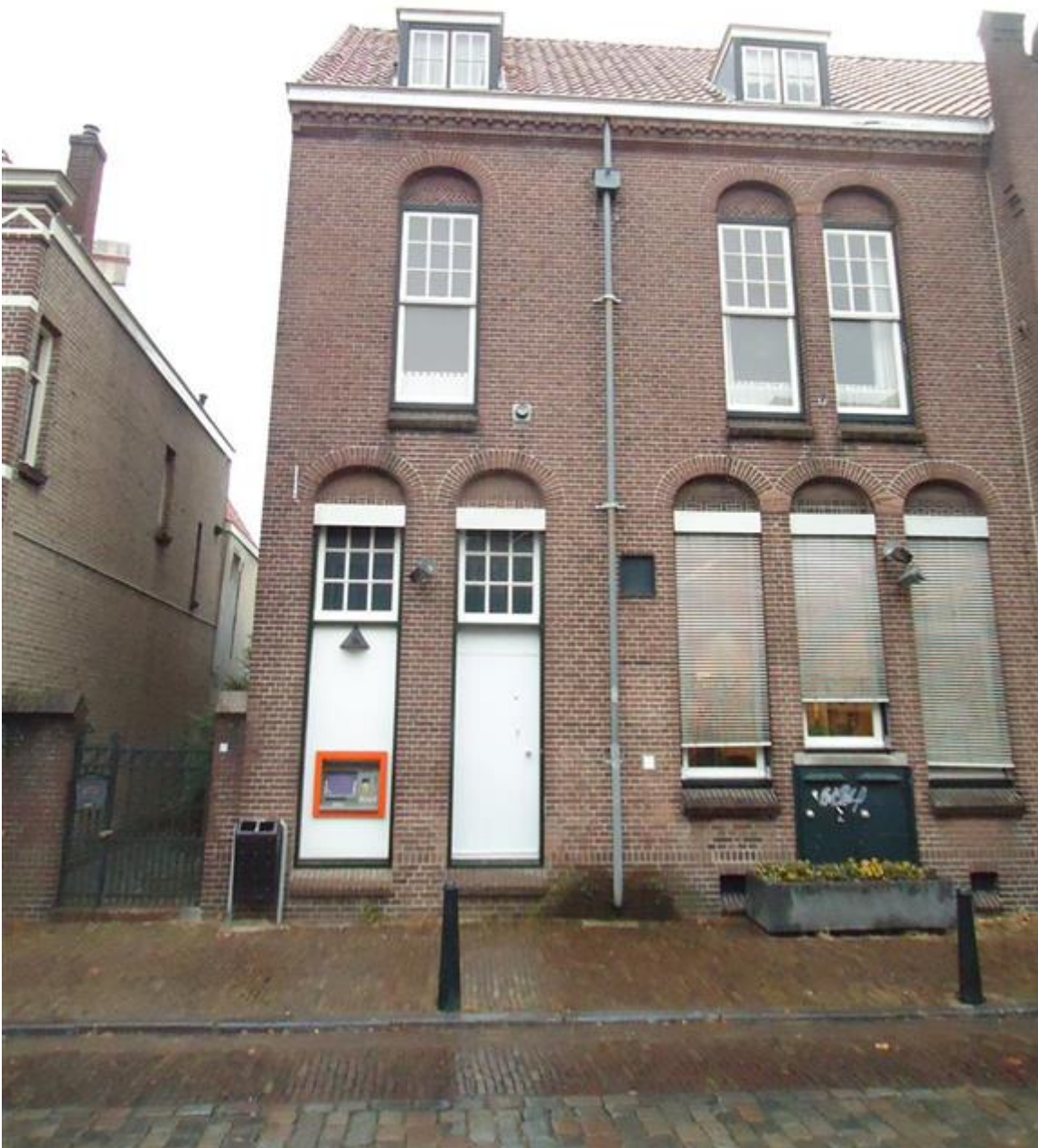
Foto geldautomaat met eigen toegangsluis
